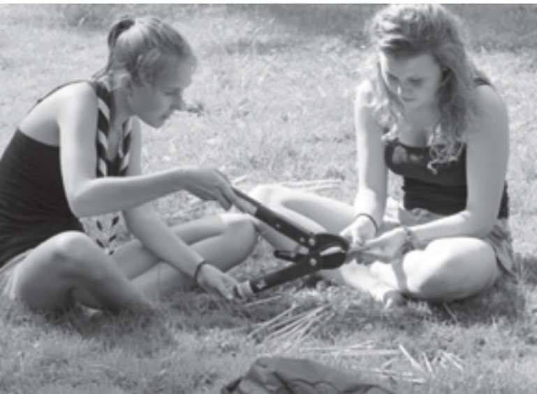
Hölzer werden auf die Länge geschnitten, damit diese bündig zum Rand des Kreuzes sitzen.
