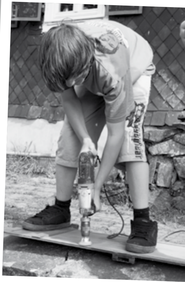
Mit Topfbürsten musste erstmal der alte Lack ab.
